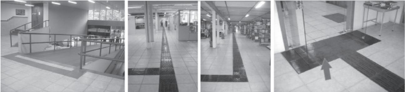
**Figura 14- Da esquerda para a direita: (1) pisos alerta indicam a presença de desnível; (2) pisos decisão associados a pisos direcional indicam cruzamento de rotas e (3) mudança de direção; pisos parada indicam início da rota.**
